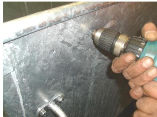
Es ist ggf. erforderlich das Lochbild des Typenschildes (Z) für die Montage am Behälterrumpf mittels eines Spiralbohrers Ø 4,2mm nachzubohren!
